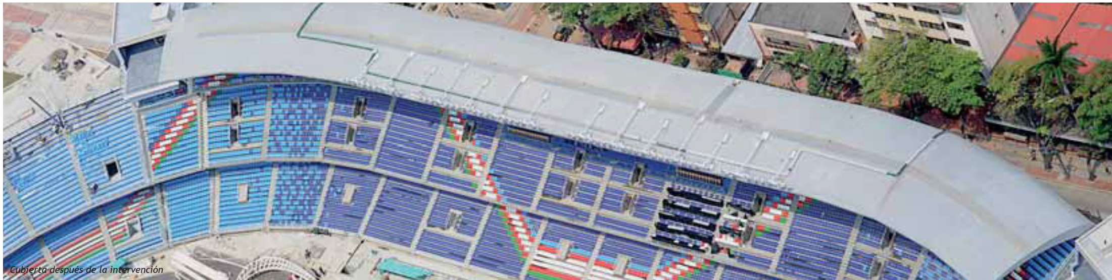
Cubierta antes de la intervención
